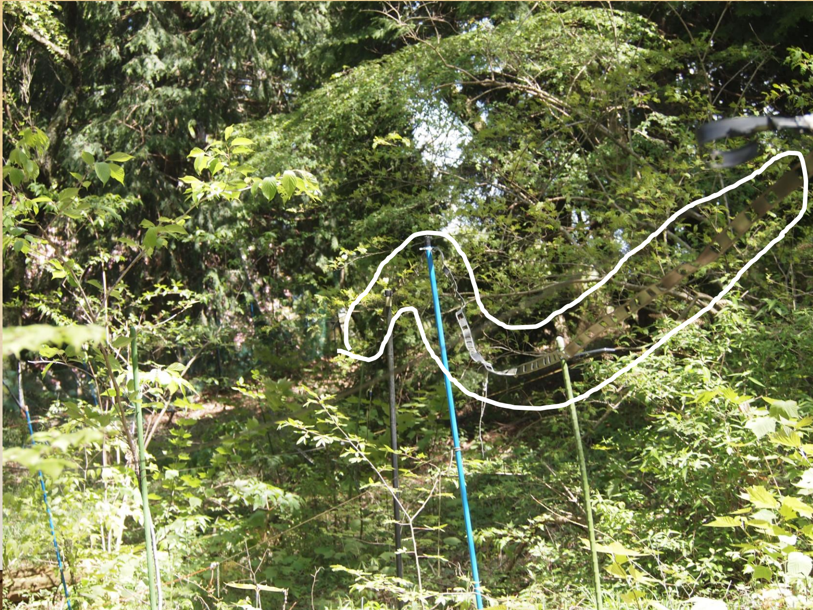
双方向ビバレージの 架設状況
